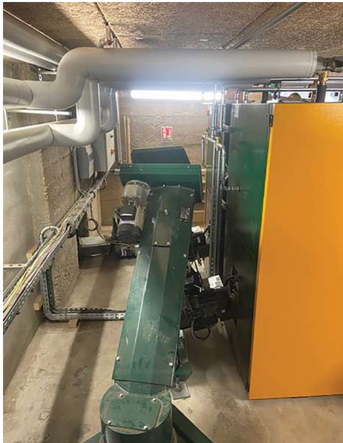
Exemple d'installation chaudière multi-combustible Commune de MARCKOLSHEIM
