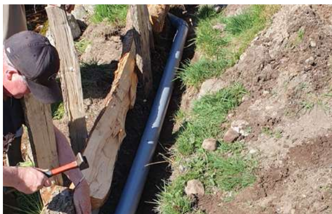
MISE EN PLACE DES TUYAUX
