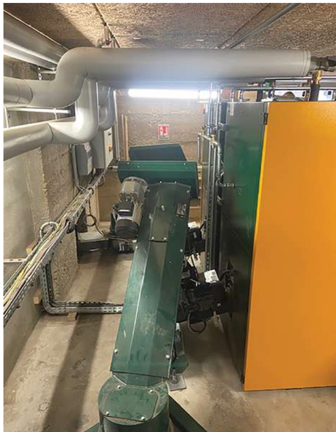
Exemple d'installation chaudière multi-combustible Commune de MARCKOLSHEIM
