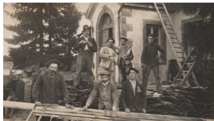
Réfection du toit de l'école en 1925
